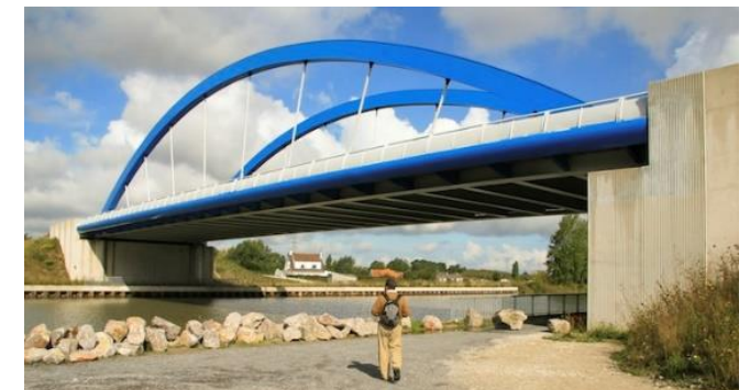
Pont de Coppenaxfort
