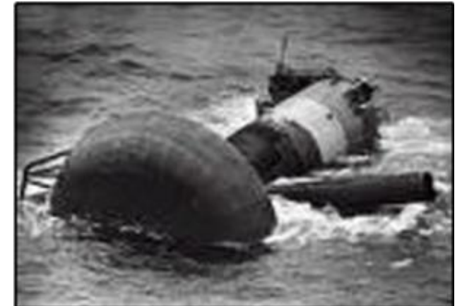
Naufrage de la plateforme Alexandre Kielland le 27 mars 1980 : fissure de fatigue présente dans l'une de ses six tubulures, reliée à une jambe qui s'est effondrée avec le reste de la plateforme.
